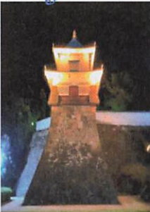
大村公園板敷櫓
